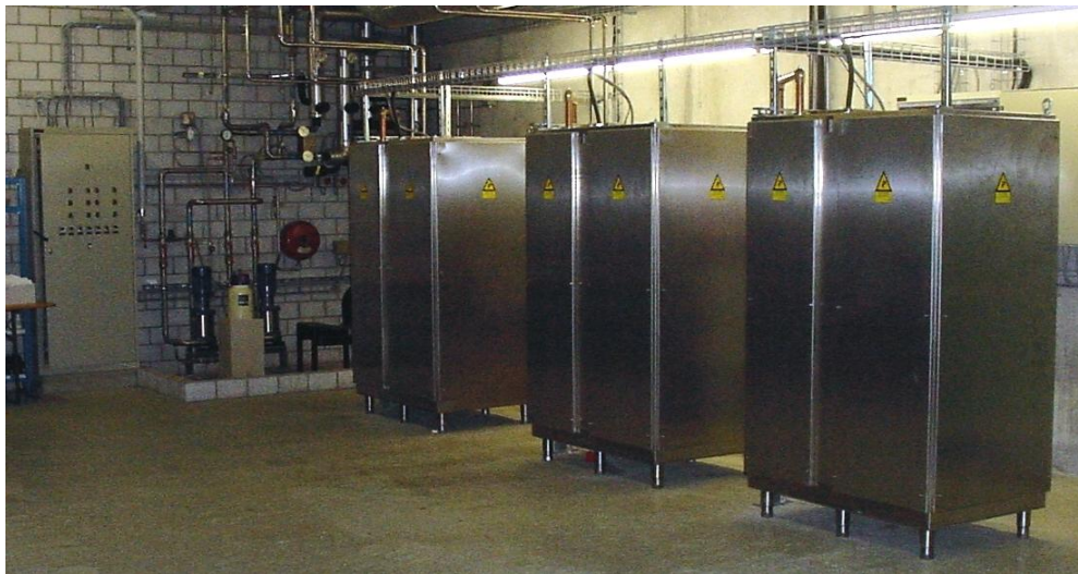
3 x générateurs de 30kW 27.12MHz et leur système de refroidissement à eau en boucle fermée
